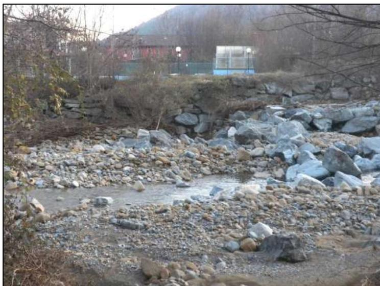
**Figura 2:** – Difesa antierosiva in destra sottoscalzata
